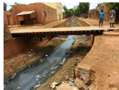
Exutoire (Collecteur aménagé)
