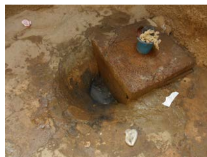
Pente de la cours dirigée vers le regard pour l'évacuation des eaux usées et pluviales
