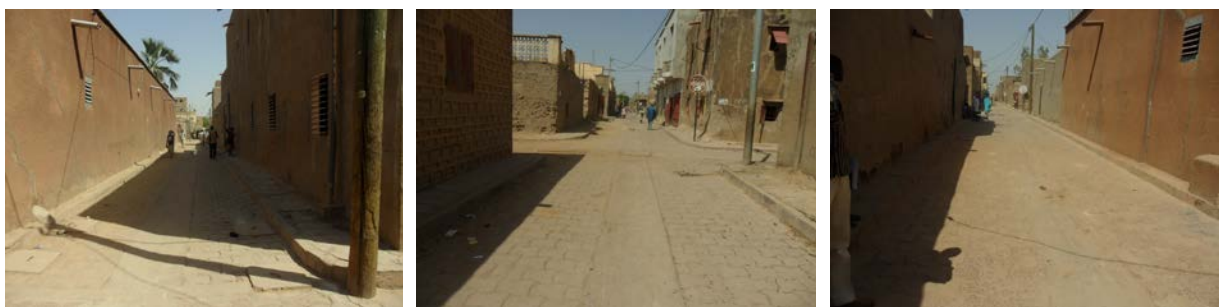
Rues assainies avec la présence du réseau
