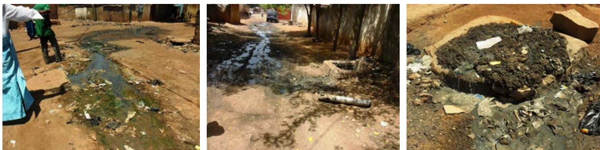
Insuffisance d'entretien du système
