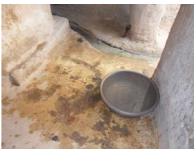
Cours de la concession munie d'une rigole pour l'évacuation des eaux usées et pluviales vers le regard
