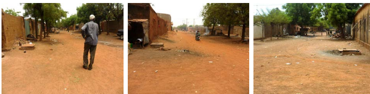
Rues assainies avec la présence du réseau
