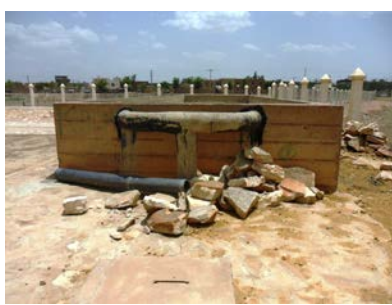
Bassin de décantation
