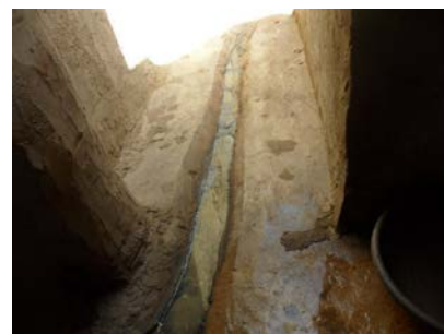
Cours de la concession munie d'une rigole pour l'évacuation des eaux usées et pluviales vers le regard
