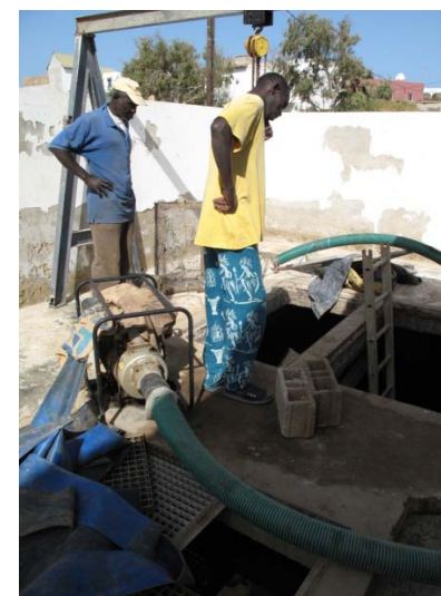
Photo 11 : Vidange d'une pompe de relevage à l'aide d'une pompe d'appoint (Dakar)
